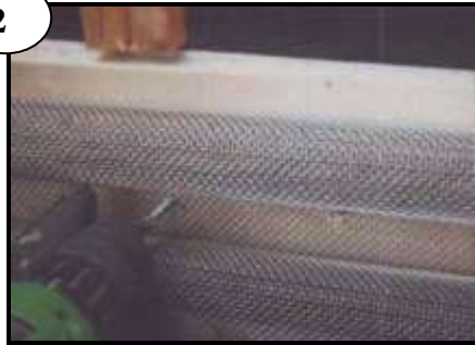
Fäst med skruv, 2-3 / meter
