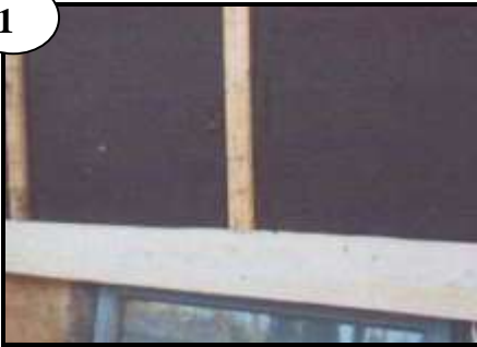
Vägg klar med anläggstyta.
